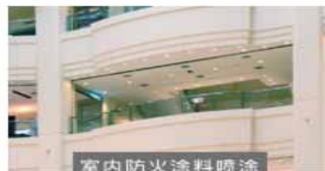
室內防火塗料噴塗 DC333飾面型防火塗料
