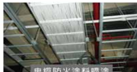
電纜防火塗料噴塗 DC309電纜防火塗料
