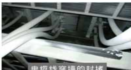
電纜線穿牆的封堵 FP05防火塗層板
