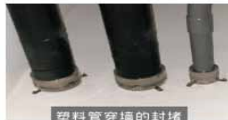
塑料管穿牆的封堵 SSCI-XX阻火圈
