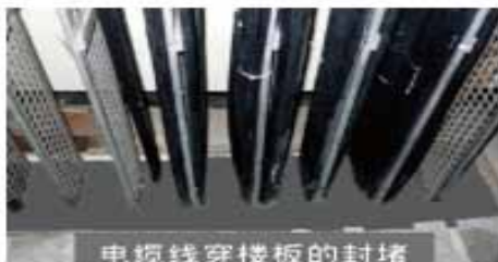
電纜線穿樓板的封堵 US150泡沫封堵材料
