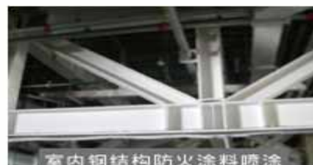
室內鋼結構防火塗料噴塗 NCB928室內超薄型 鋼結構防火塗料
