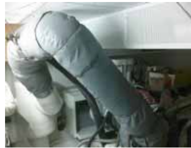
引擎排氣管路保溫
