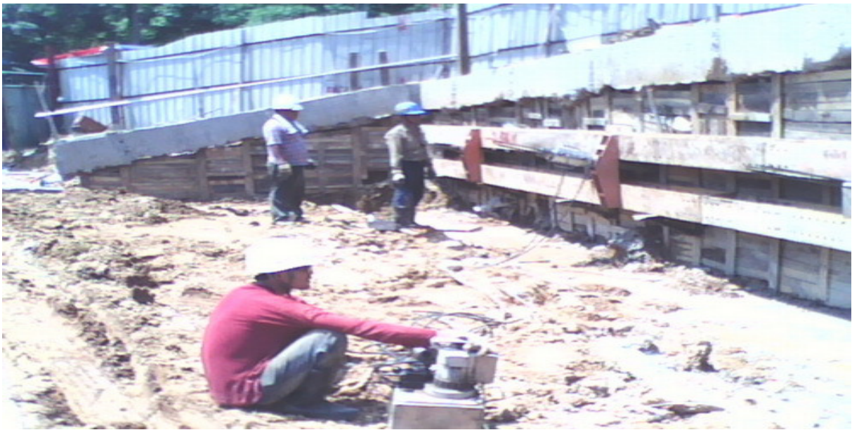
五股全懋建設地錨施預力工程
