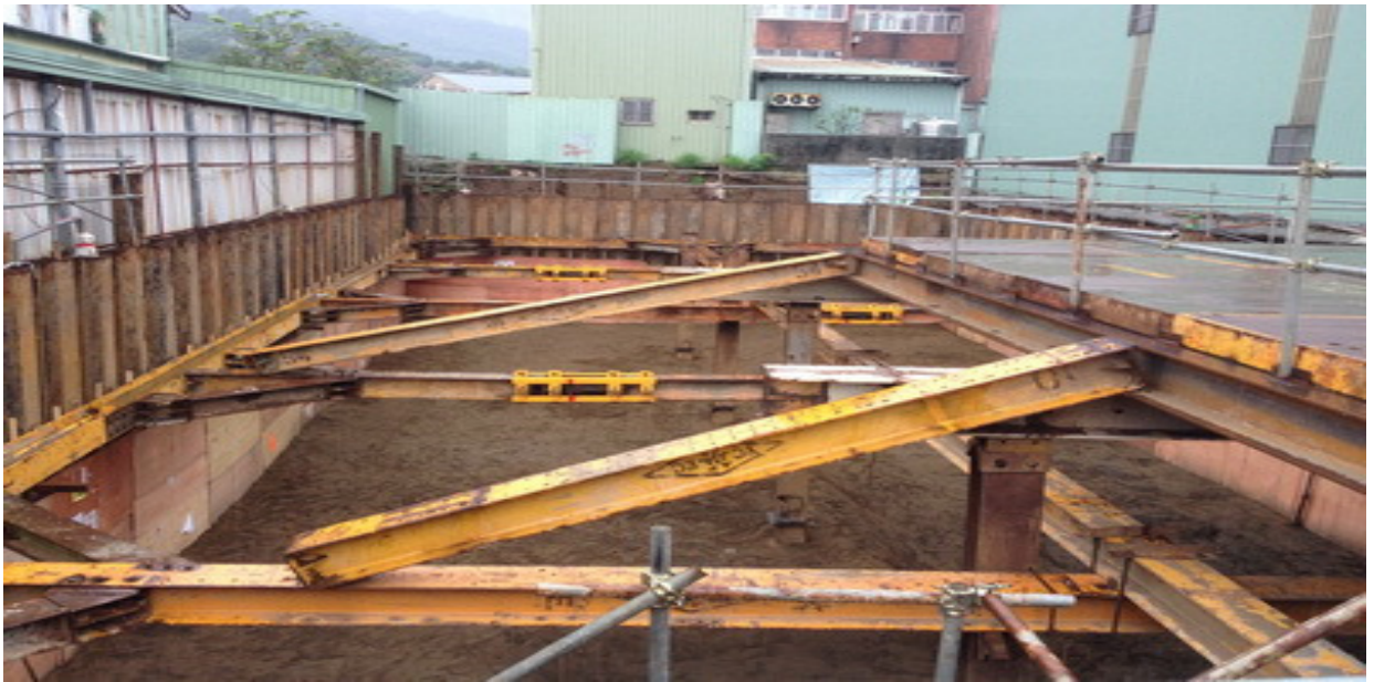
八里振誠營造鋼板樁工程
