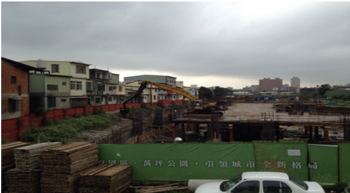
中壢和發建設鋼軌拔除工程
