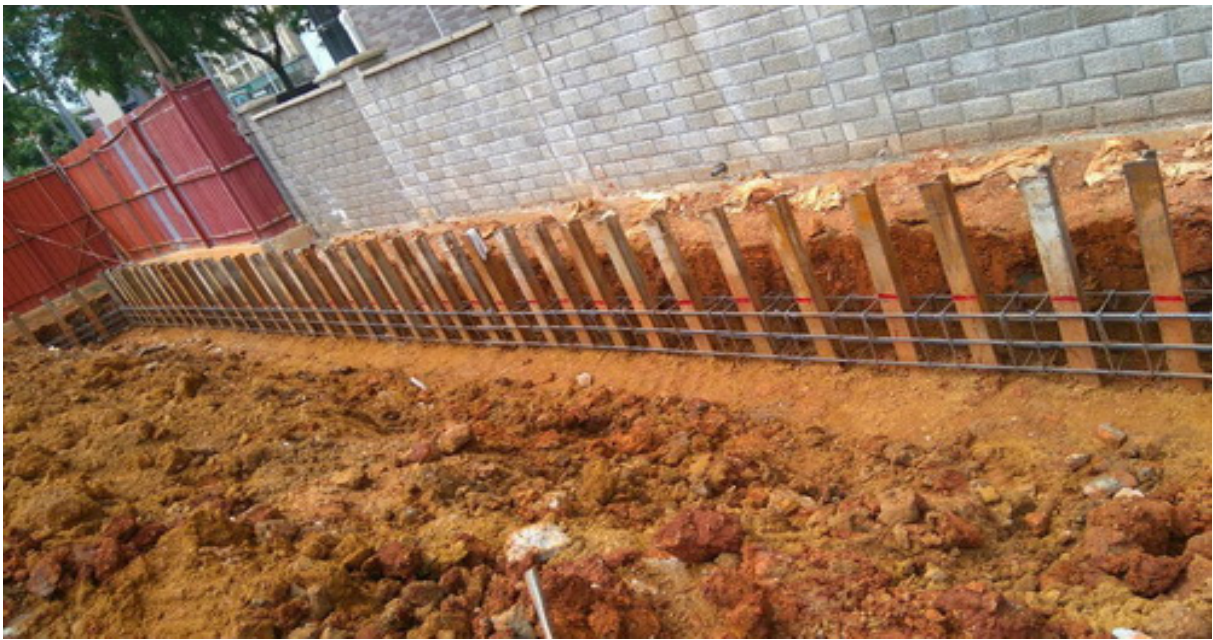
蘆竹勤翔營造遊六排樁工程
