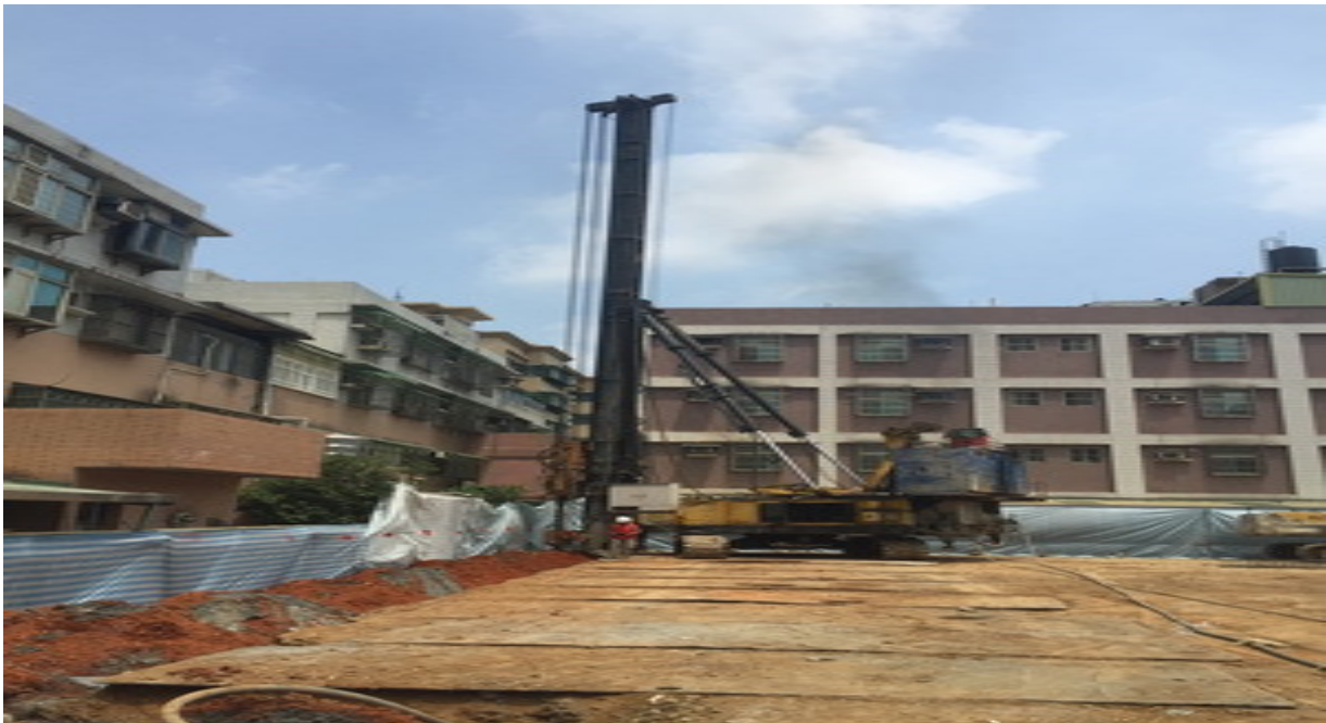
龜山興合力鋼軌壓樁工程
