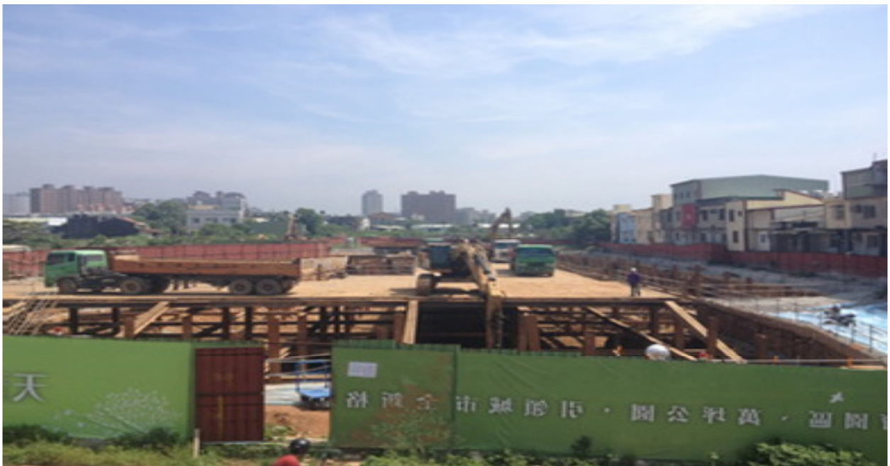
中壢和發建設支撐構台工程
