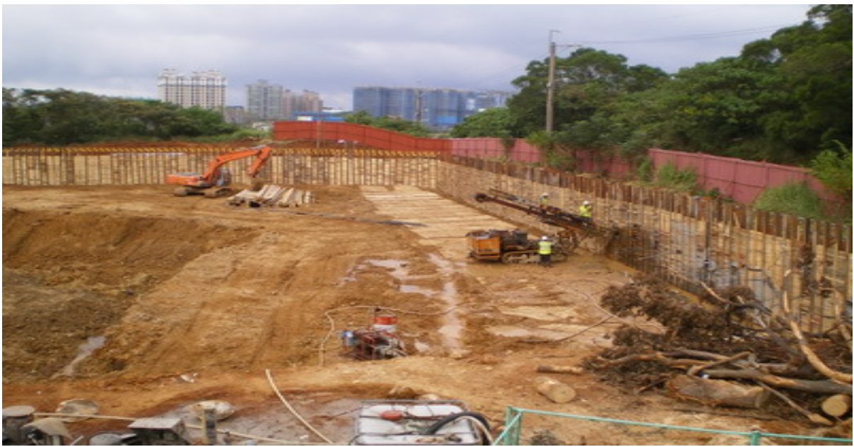
淡水興合力鋼軌背拉工程
