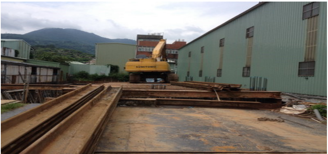
八里振誠營造鋼板樁拔除工程
