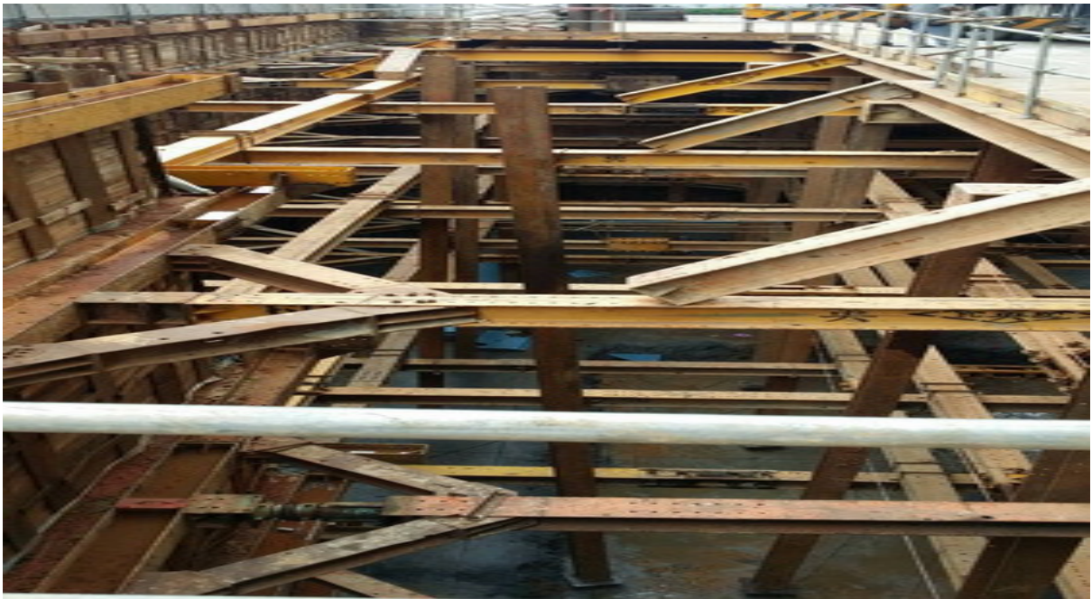
林口玄泰支撐工程
