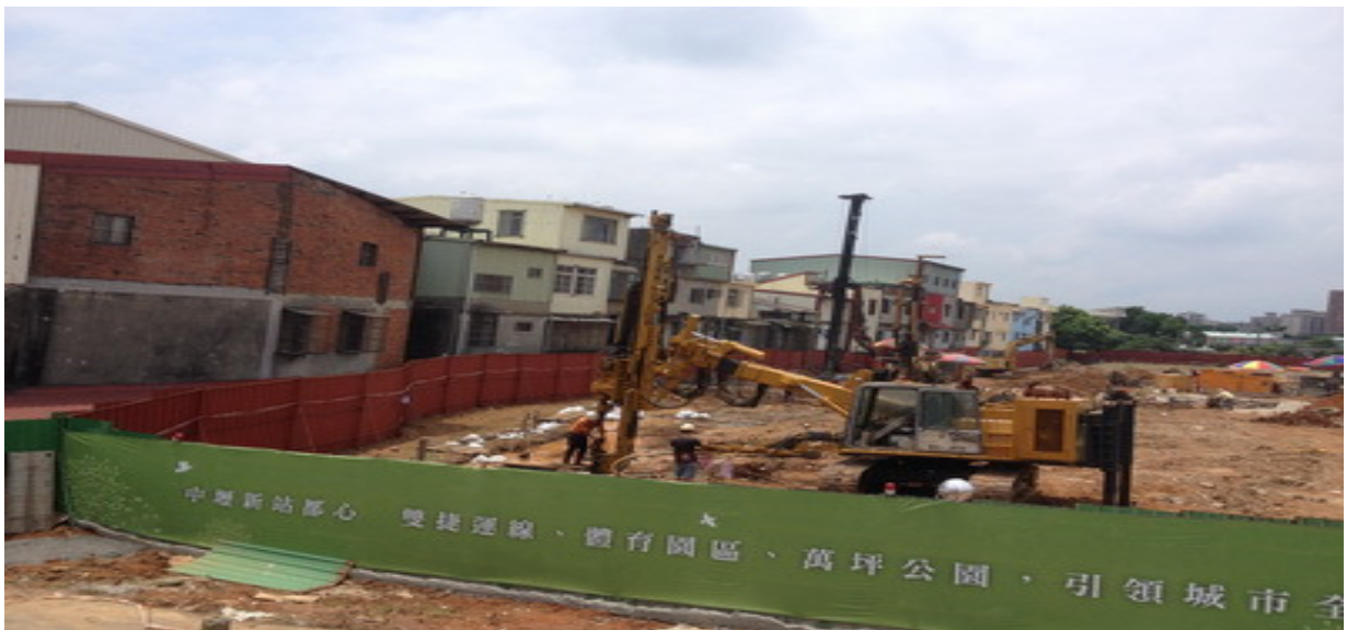
中壢和發建設鑽堡引孔工程
