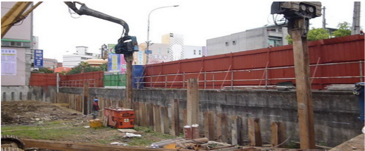
觀音英城營造協益電子中樁打設工程
