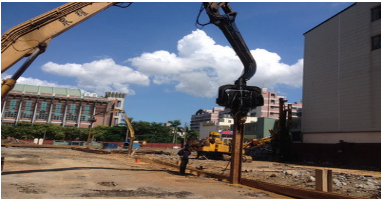
內壢佳銘建設型鋼樁打設
