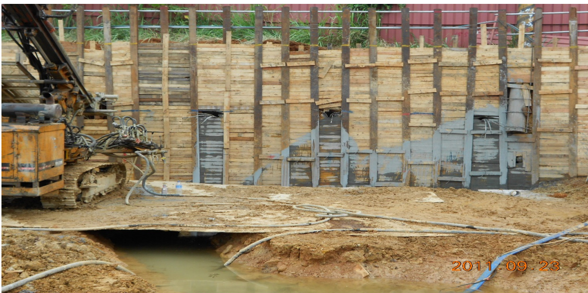
淡水興合力原石樸莊地錨打設工程
