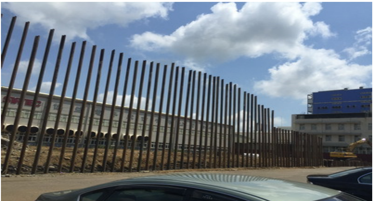
觀音英城營造協益電子鋼軌樁打設工程
