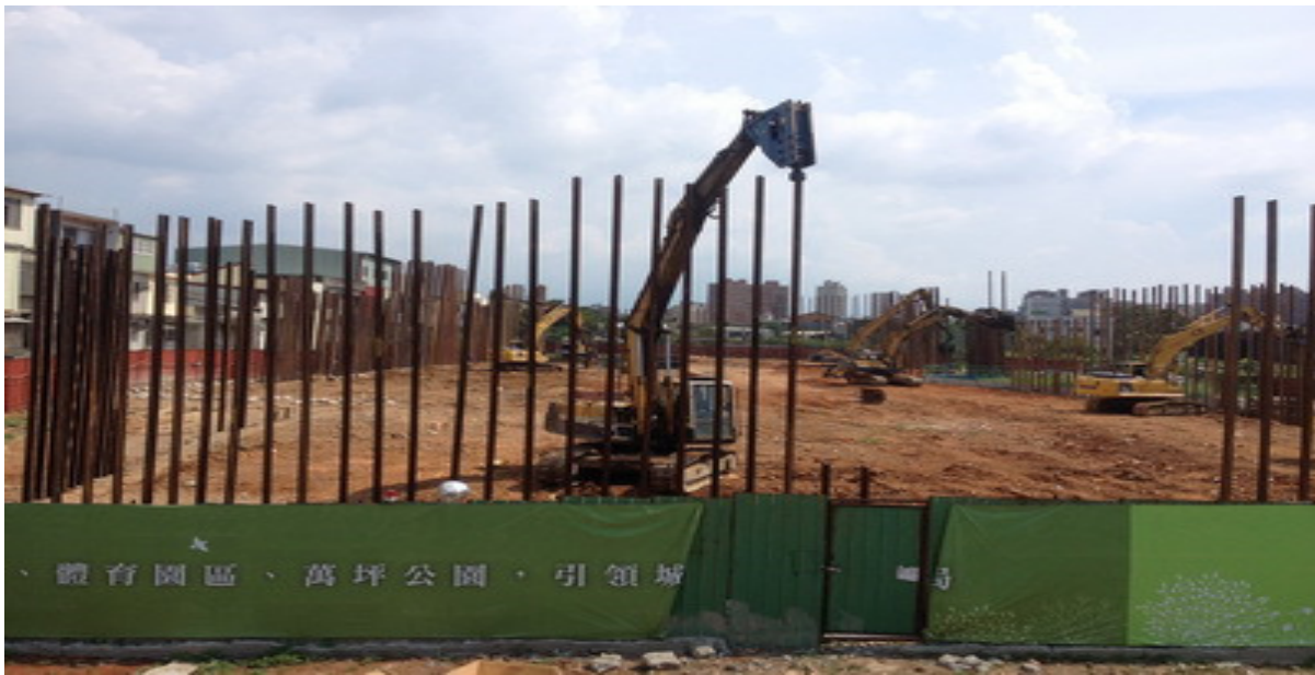
中壢和發建設鋼軌打設工程
