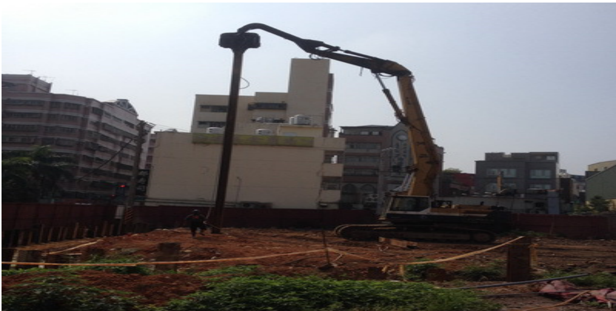
內壢佳銘建設中間柱樁打設工程
