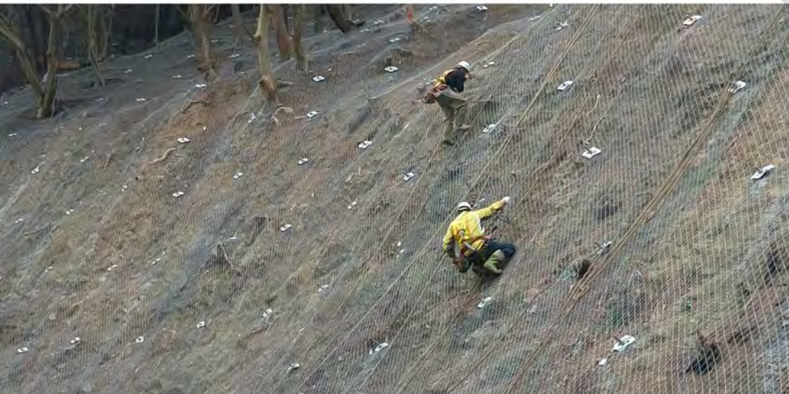
d. 岩坡穩定金屬網承壓鉸鎖定 e. 鋪設岩坡金屬網
