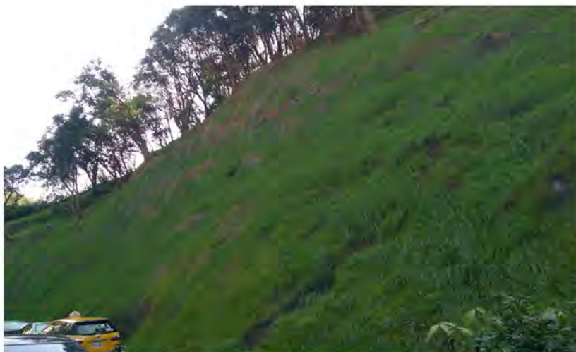
▲化「危坡」為美麗的「青青草坡」
