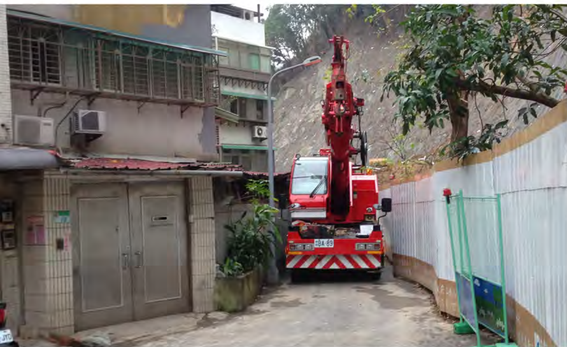
▲環山路一段59巷14弄路面最狹小處約2m
