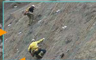
岩坡穩定金屬網系統 以點、線、面進行邊坡整治
