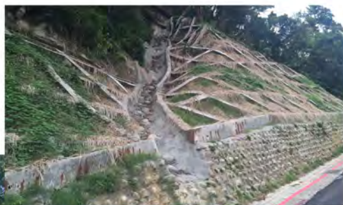
傳統混凝土型框格樑護坡 ◀
