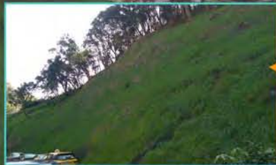
邊坡整治完成 安全、綠化的居住環境
