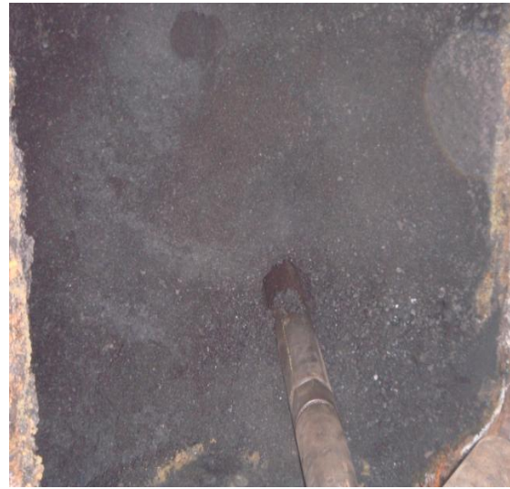
高壓鋼管置入煤炭堆積中
