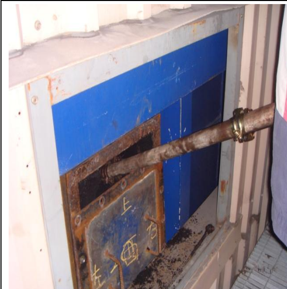
高壓鋼管置入煤炭堆積中
