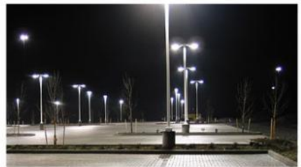
路燈、大型停車場
